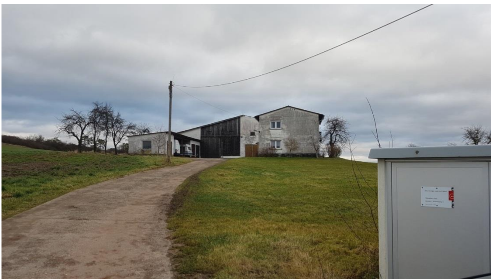
Blick Richtung Osten zum Aussiedlerhof und zur Trafostation
